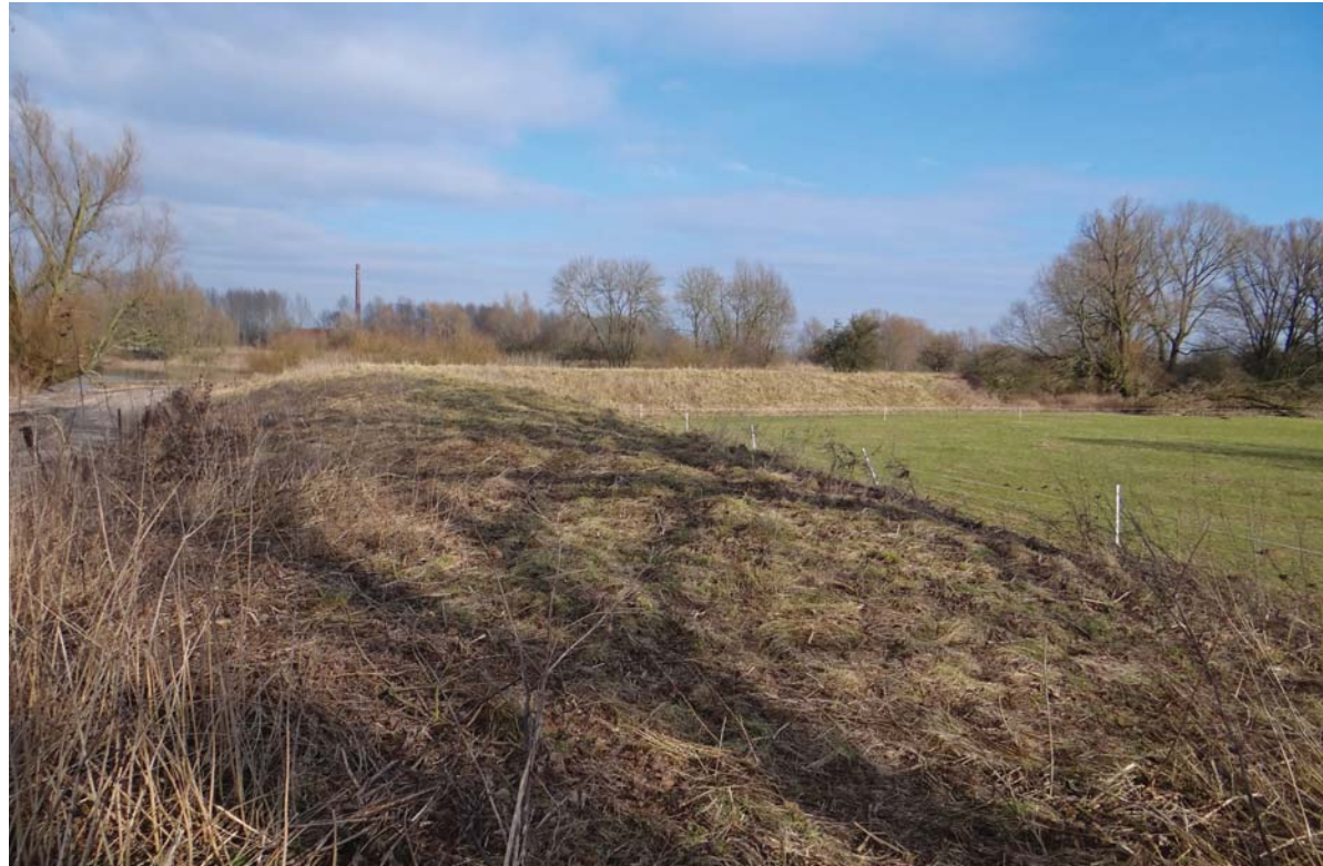
Bij de dijkafrit naar terrein De Bunswaard oogt het Weurtsche Straatje nog helemaal gaaf. Hier en daar zou het dijkje kunnen worden gerestaureerd om de betekenis van het straatje als waterkering beter te laten uitkomen.
