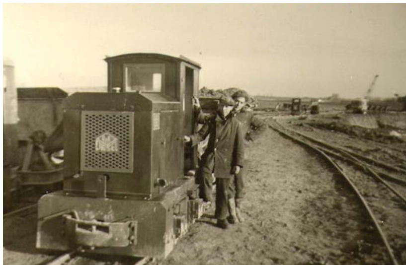
Met een kipkarrentrein wordt de klei vervoerd naar De Staartjeswaard. Bron: http://www.oudbeuningen.nl/steenoven/staartjeswaard
