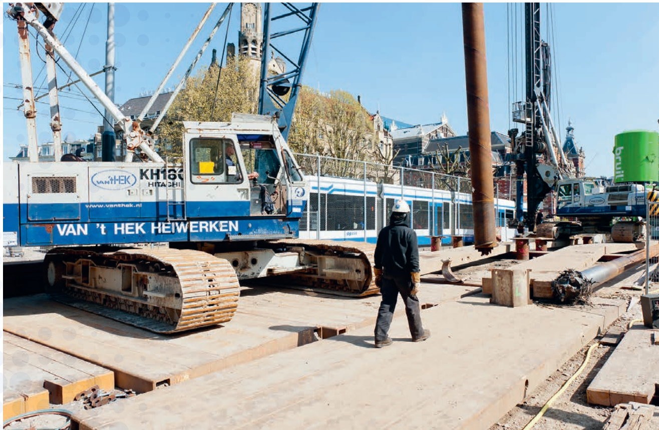
Heiwerkzaamheden door Gebr. Van 't Hek
