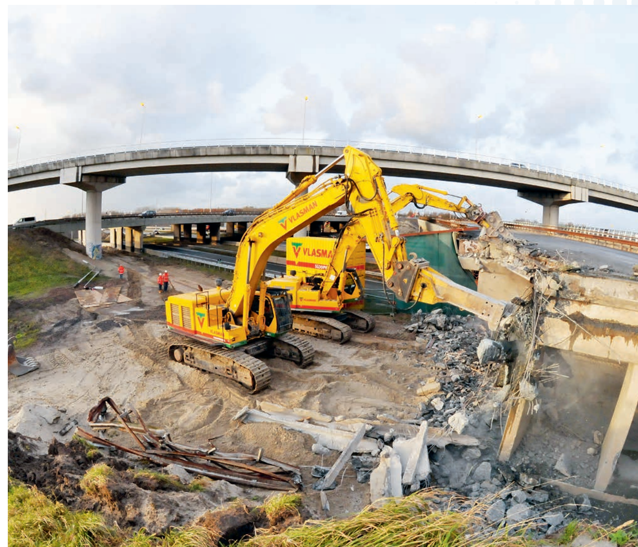
Reconstructie door Totaalsloopbedrijf Vlasman
