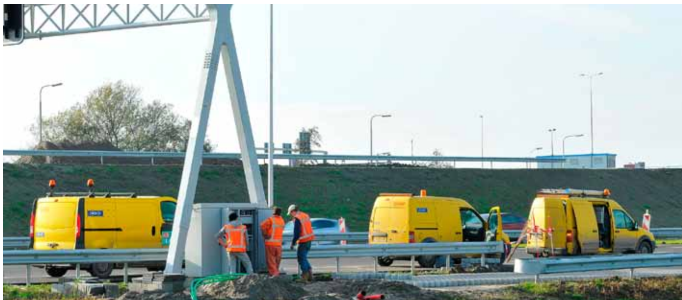
Werkzaamheden aan de snelweg
