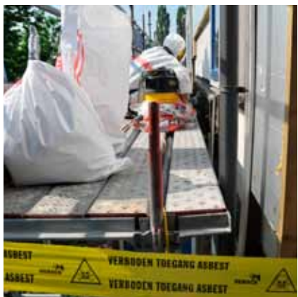
Asbestsanering Furkabaan Utrecht
